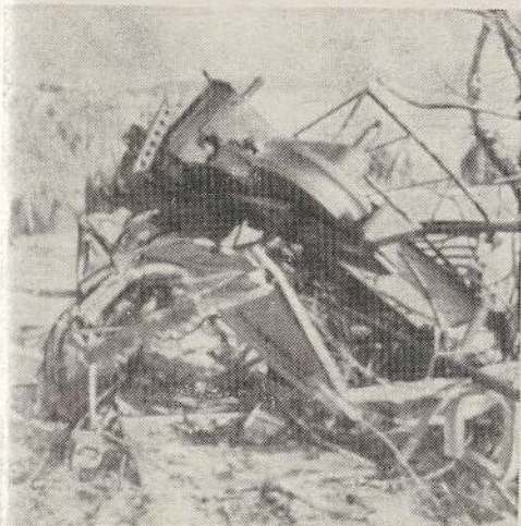
Kabina lanovky po zřícení
