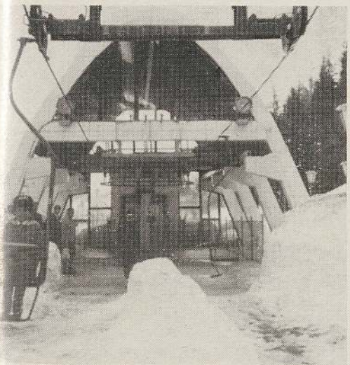
Zajímavá stanice lanovky v Pamporovu
