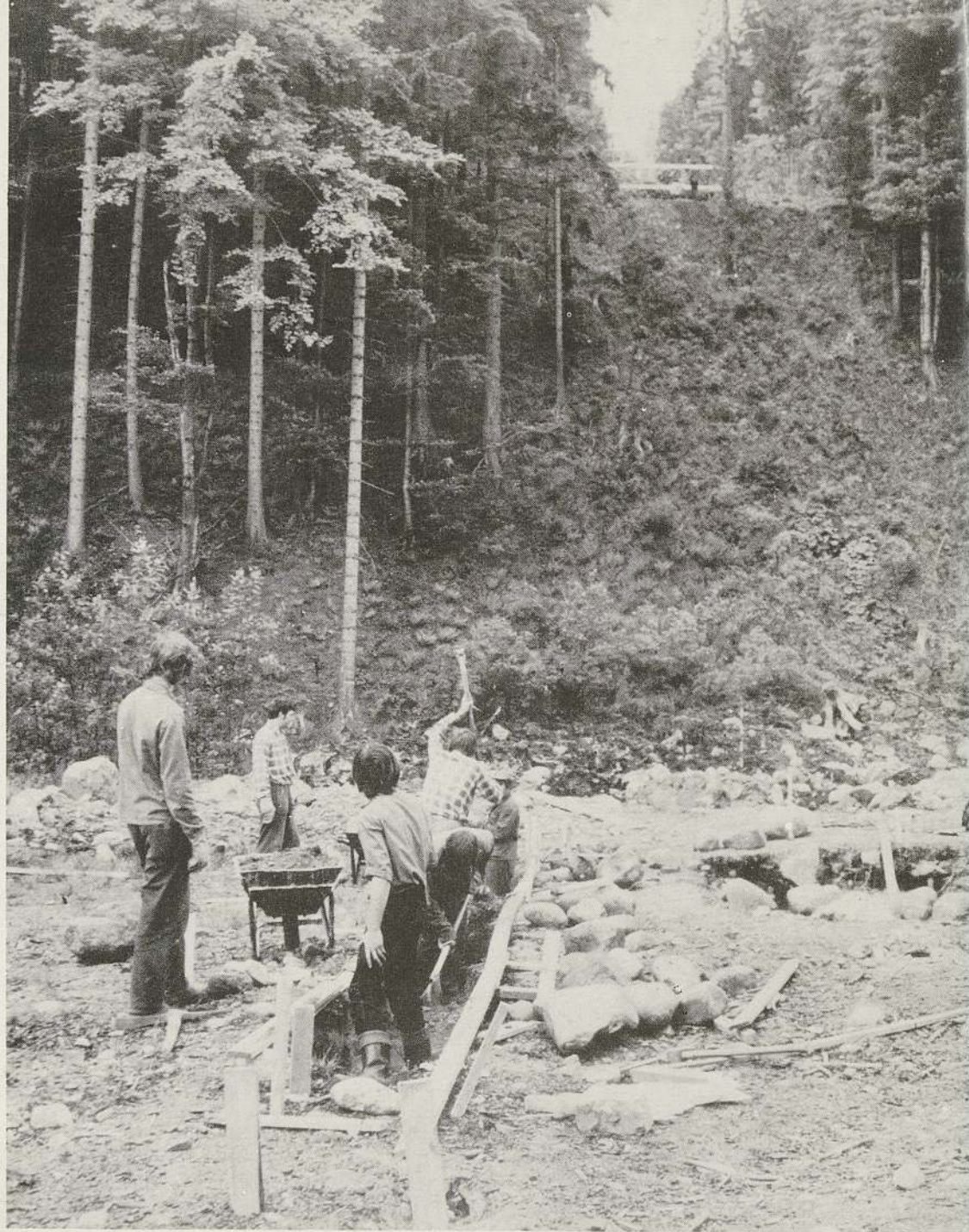
Oblastní správa tělovýchovných zařízení v Krkonoších staví sedačkovou lanovku na Medvědin. Výkopové práce v místě spodní stanice lanovky.
