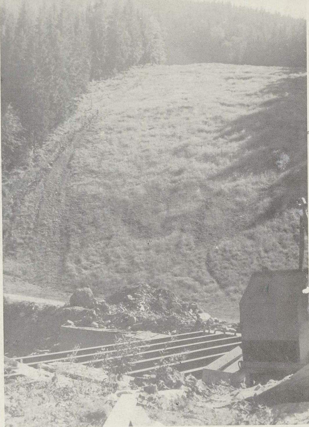
Nové přemostění potoka pod slalomovým svahem na lyžařském stadiónu ve Špindlerově Mlýně.
