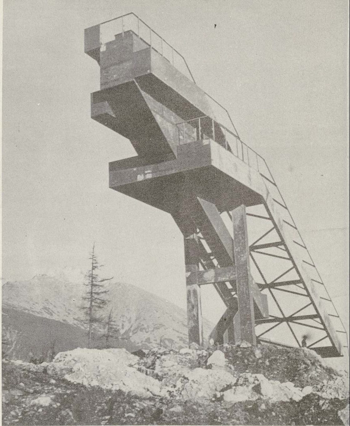
Ocelová konstrukce středního můstku v Mlynické dolině čeká na snůh.
