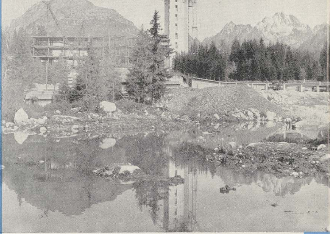
Výstavba nové pošty a budovy spojů na Štrbském Plese pre MS 1970.
