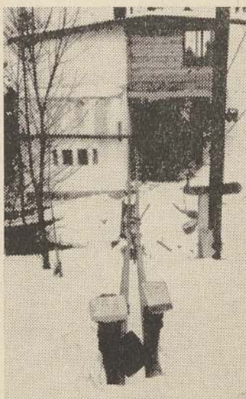
Detail rozvodného potrubí stlačeného vzduchu a vody.
