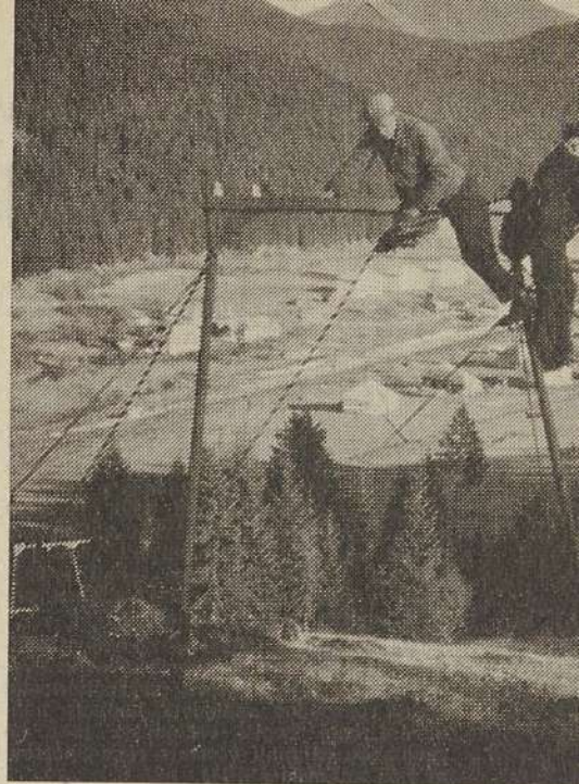
Stavba lyžiarskeho vleku v Mlynkoch.
