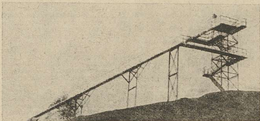
POHLED NA OCELOVOU NÁJEZDOVOU VĚŽ V NÝDKU.
