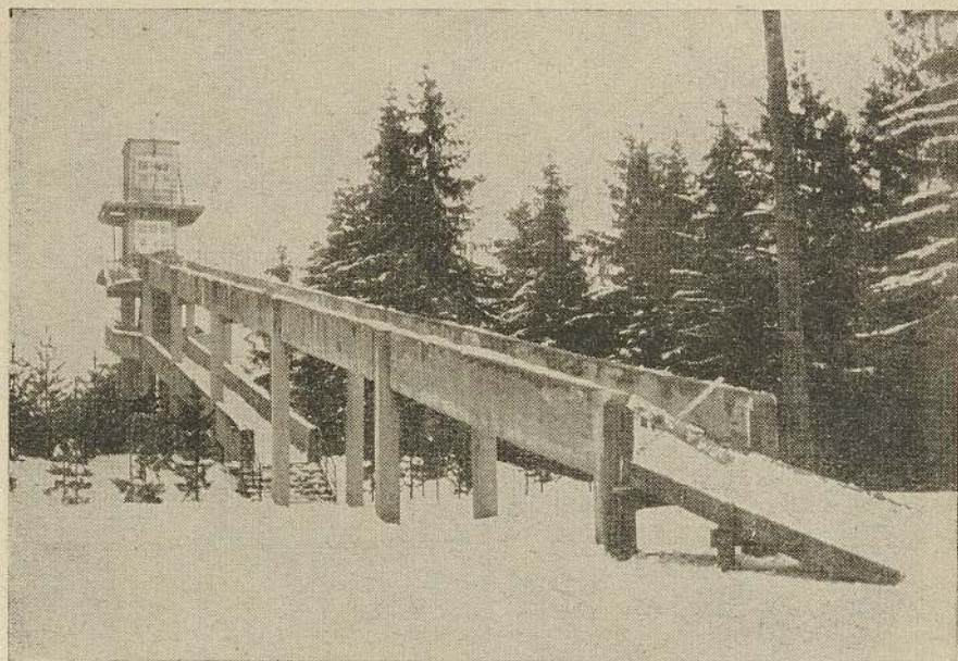
Železobetonová startovní věž sáňkařské dráhy v Krynici
