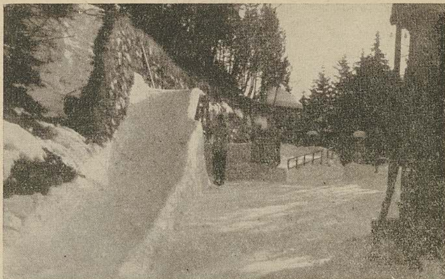
Startovací můstek schatzalpské dráhy s rozestavěnou sněhovou zdí. Až u pravého kraje stojí startovací budka.
